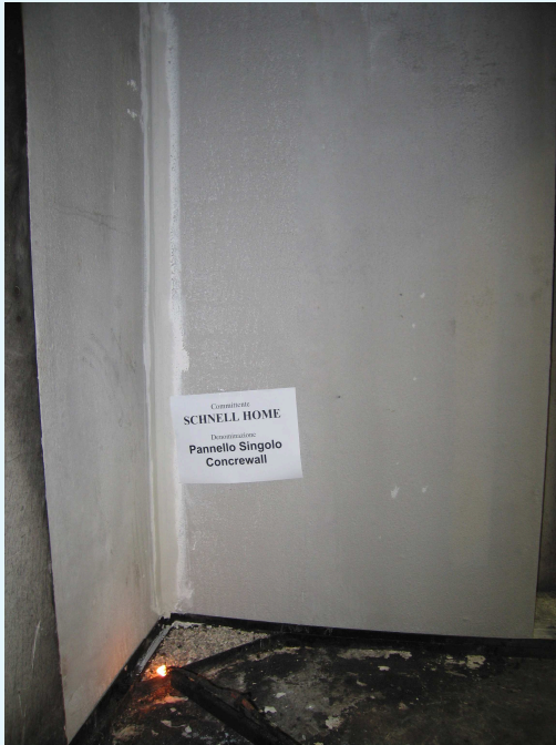
Vista totale dell'ala lunga della superficie esposta. Total view of the exposed surface of the long wing.
