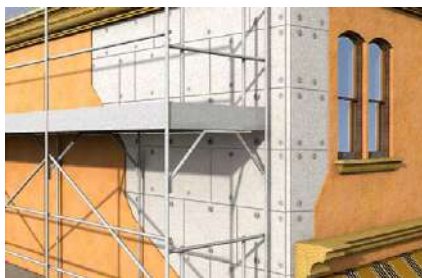
Fissaggio di pannelli isolanti
